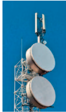
Bild 3. Beispiel für ein Richtfunk-Backhaul-System.
