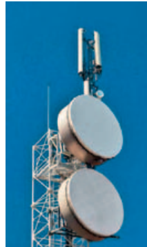
Bild 3. Beispiel für ein Richtfunk-Backhaul-System.
